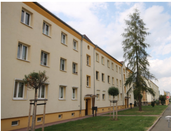
Hauseingangsseite Haus Nr. 228-232
